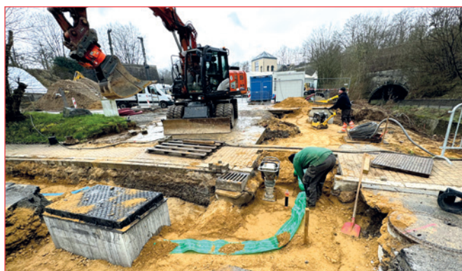
Travaux pour nouveau centre culturel à Steinfort
