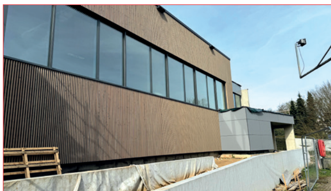
Construction piscine (phase 1) à Steinfort
