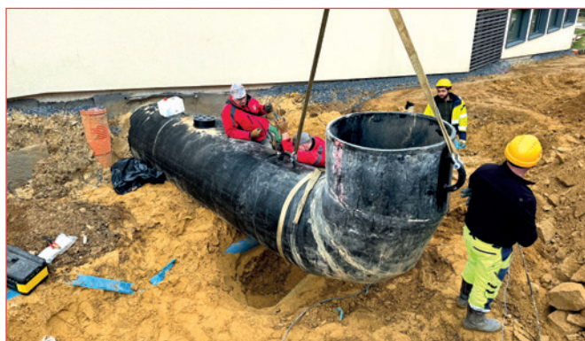
Construction piscine (phase 1) à Steinfort
