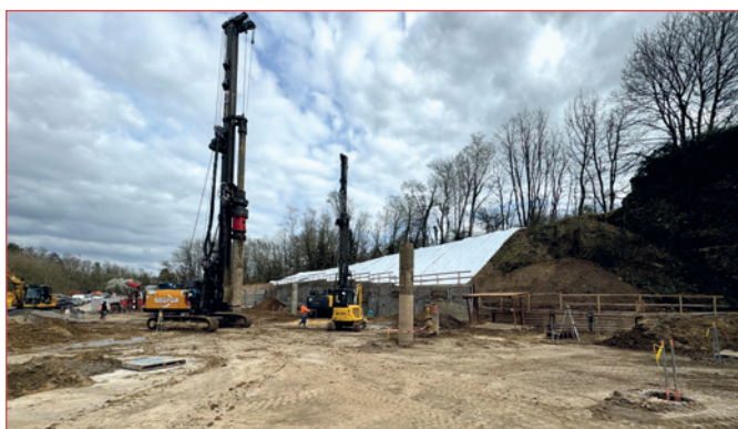
Travaux pour nouveau centre culturel à Steinfort
