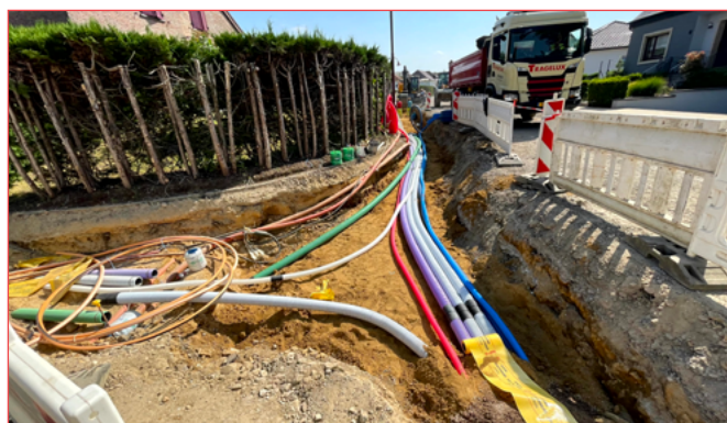
Cité Herrenfeld à Steinfort Travaux de réseaux Rue Maria Theresa
