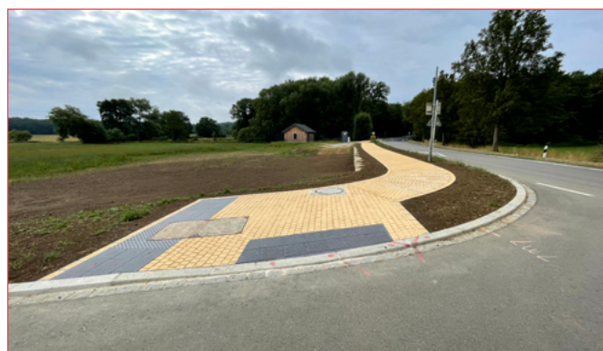
Réaménagement chemin piétons à Grass
