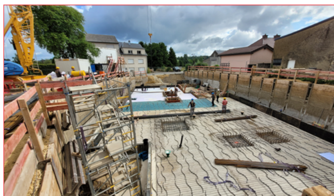
Création logements centre de Hagen
