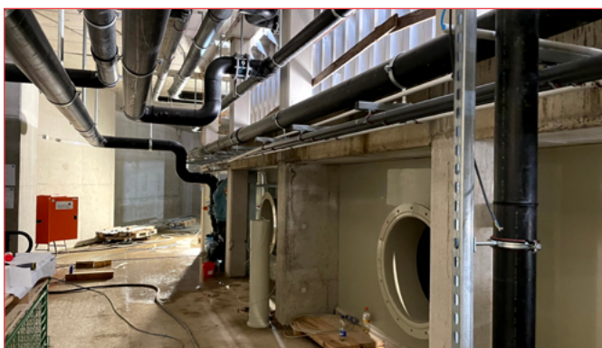
Construction piscine (phase 1) à Steinfort Technique de la piscine
