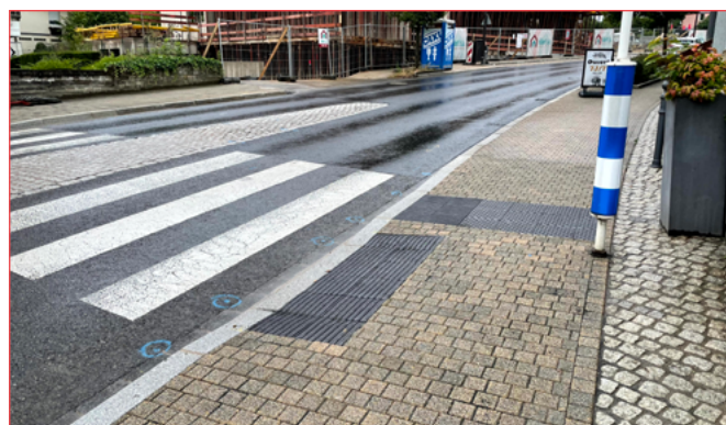
Réaménagement passage piétons Route d'Arlon à Steinfort
