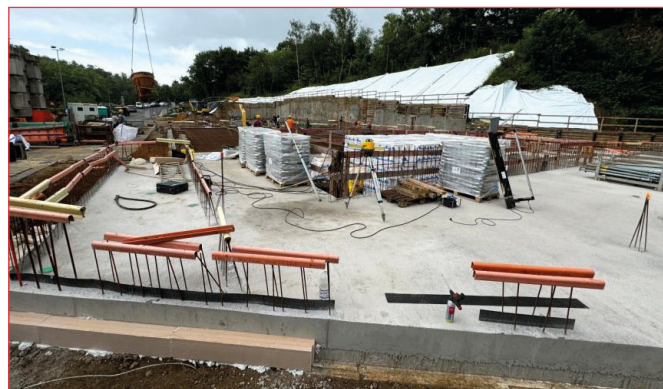
Travaux pour nouveau centre culturel à Steinfort
