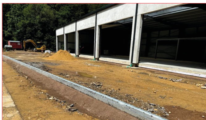
Construction Hall Régie
