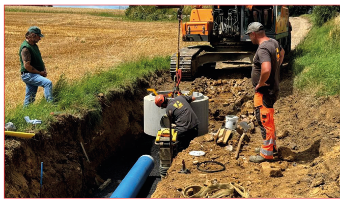
Aménagement d'un nouveau château d'eau
