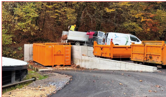
Construction Hall Régie
