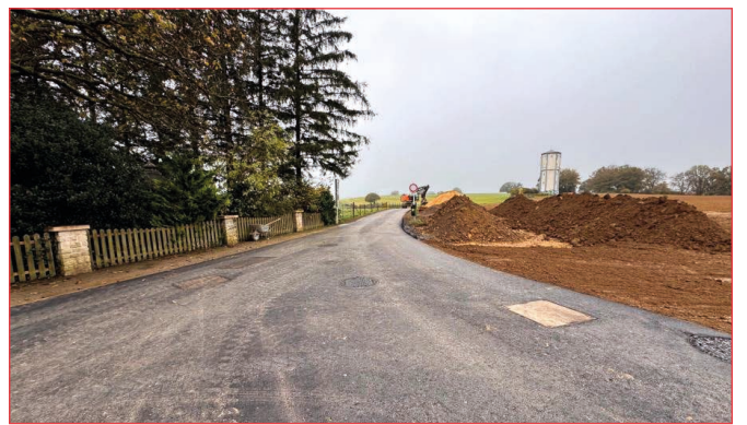
Aménagement d'un nouveau château d'eau
