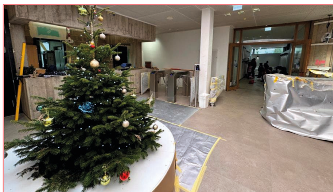
Construction piscine (phase 1) à Steinfort
