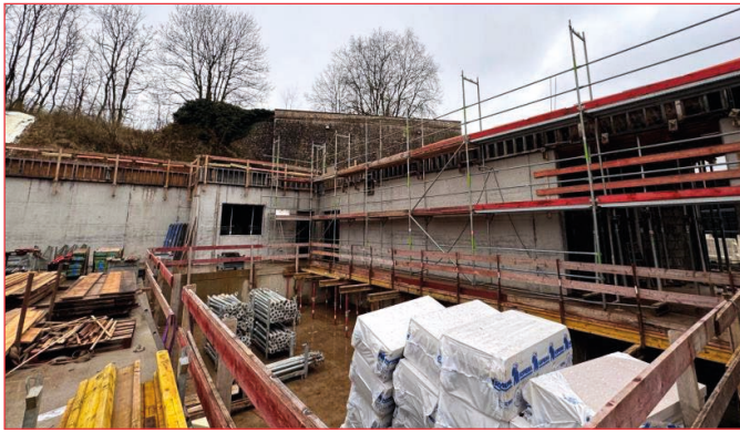
Travaux pour nouveau centre culturel à Steinfort
