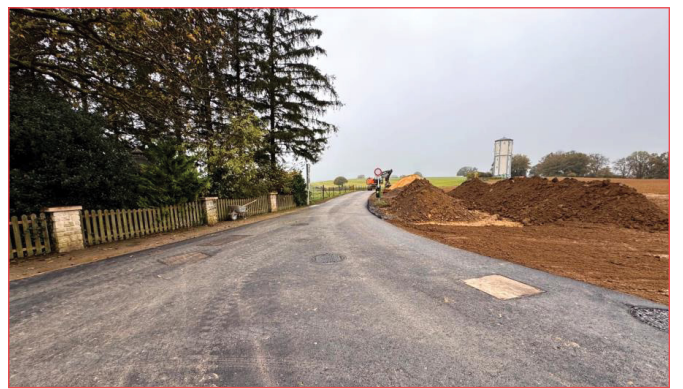
Aménagement d'un nouveau château d'eau
