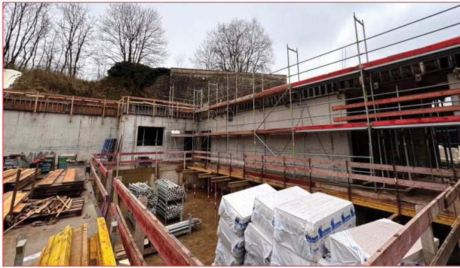
Travaux pour nouveau centre culturel à Steinfort
