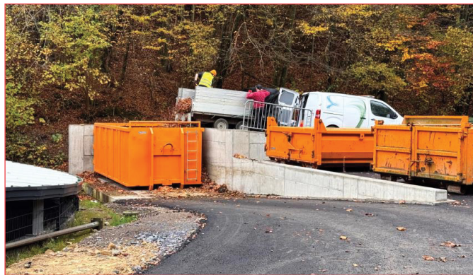
Construction Hall Régie
