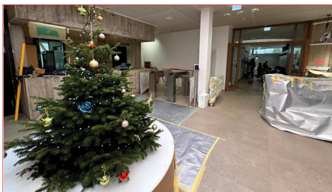
Construction piscine (phase 1) à Steinfort
